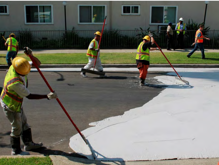
Hitzereduktion über einen reflektierenden Strassenanstrich Pilotprojekt «Coole Pavement» im Los Angeles
