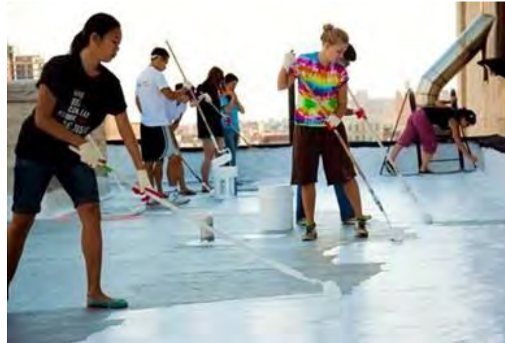
Hitzereduktion durch weissen Anstrich Projekt «White Roof» New York
